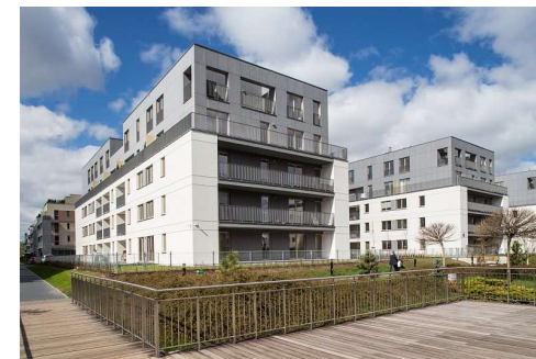
Ostoja-Wilanów (etapa 6.A, edificio C2).
